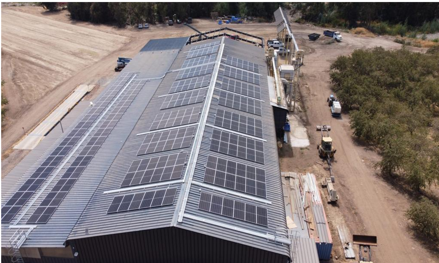
Figura 2. Ejemplo de cubierta con paneles solares
