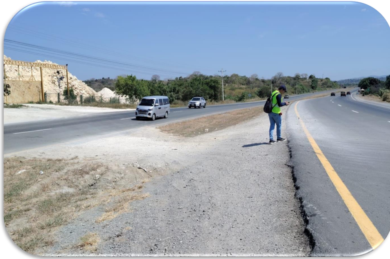
Figura 4. Acceso NO permito dentro de la curva.
