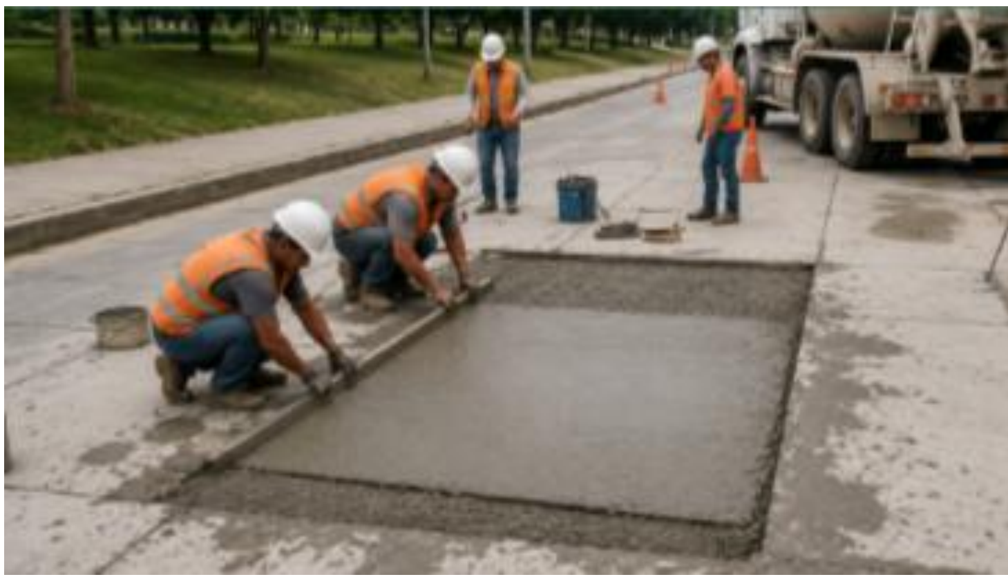
Rehabilitación de losas HCP
