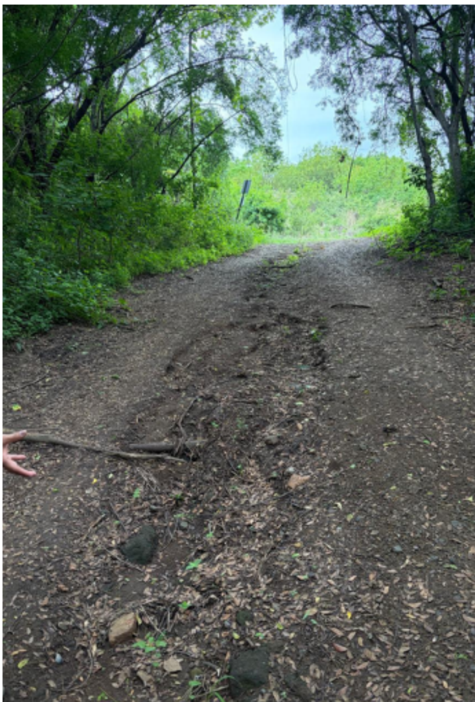
Evidencia fotográfica obtenida durante las inspecciones de campo en el sendero peatonal del lago de Ingenierías de la ESPOL, donde se observan sectores con erosión superficial, pérdida de material y deterioro del camino asociados con el paso de la escorrentía.
