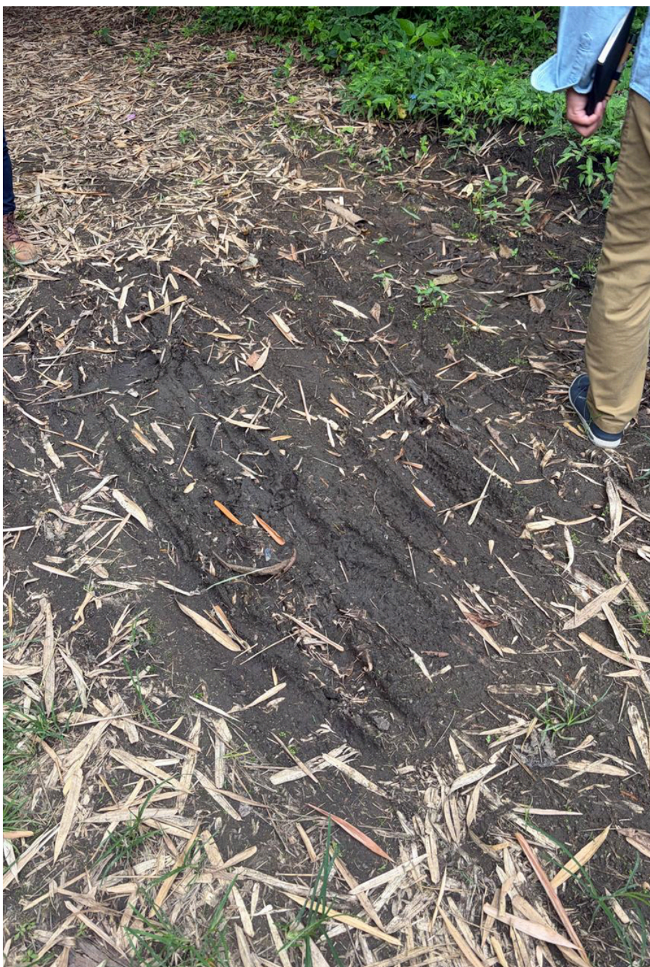
Evidencia fotográfica obtenida durante las inspecciones de campo en el sendero peatonal del lago de Ingenierías de la ESPOL, donde se observan sectores con erosión superficial, pérdida de material y deterioro del camino asociados con el paso de la escorrentía.
