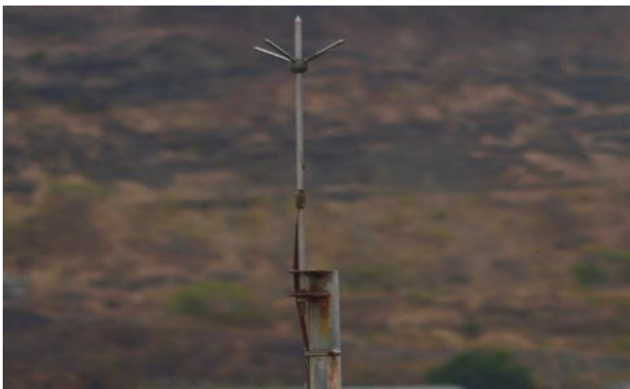
Ilustración 6. Soporte de Pararrayo de la torre inspeccionada
