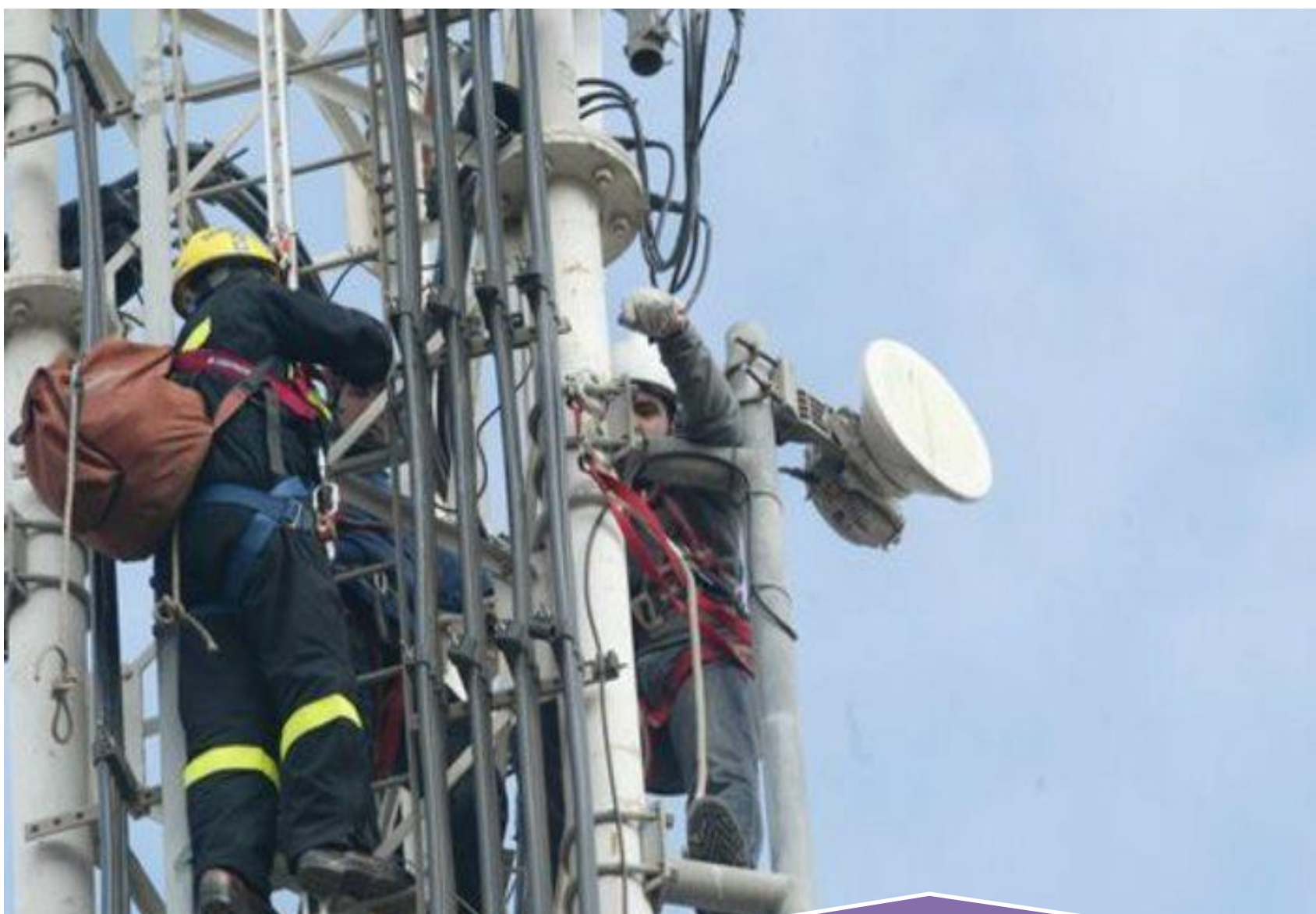
Ilustración 1. Inspección a una Torre de Telecomunicaciones
