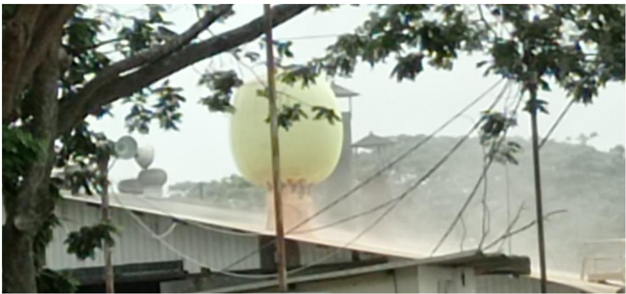
Ilustración 1: Escape de indeseado de producto.
