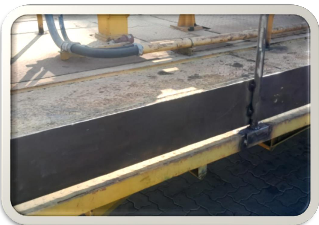
Instalación de rodapié
