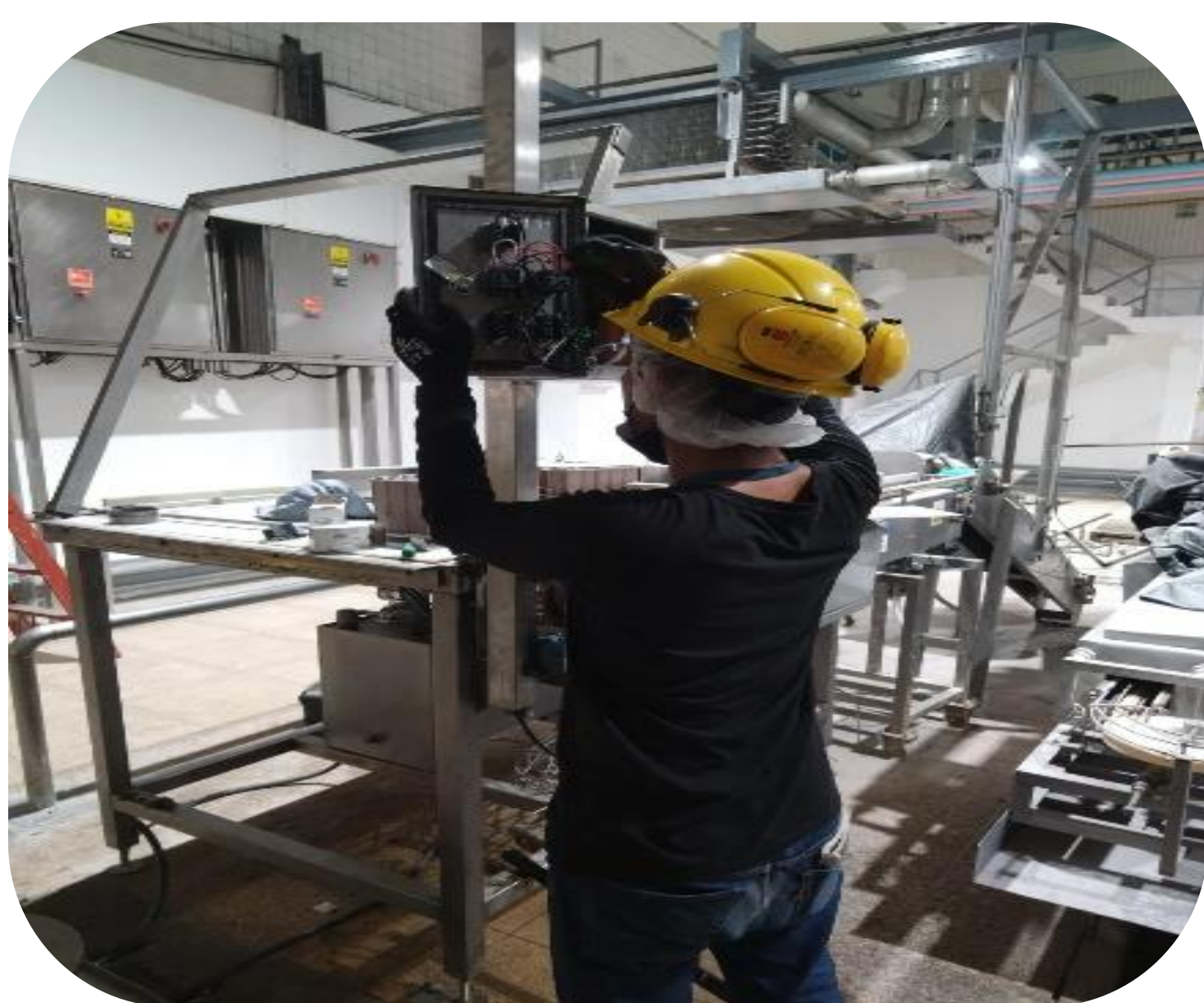
Inspección y diagnóstico de las conexiones eléctricas actuales tablero de control y fuerza del enjaulador de latas de atún
