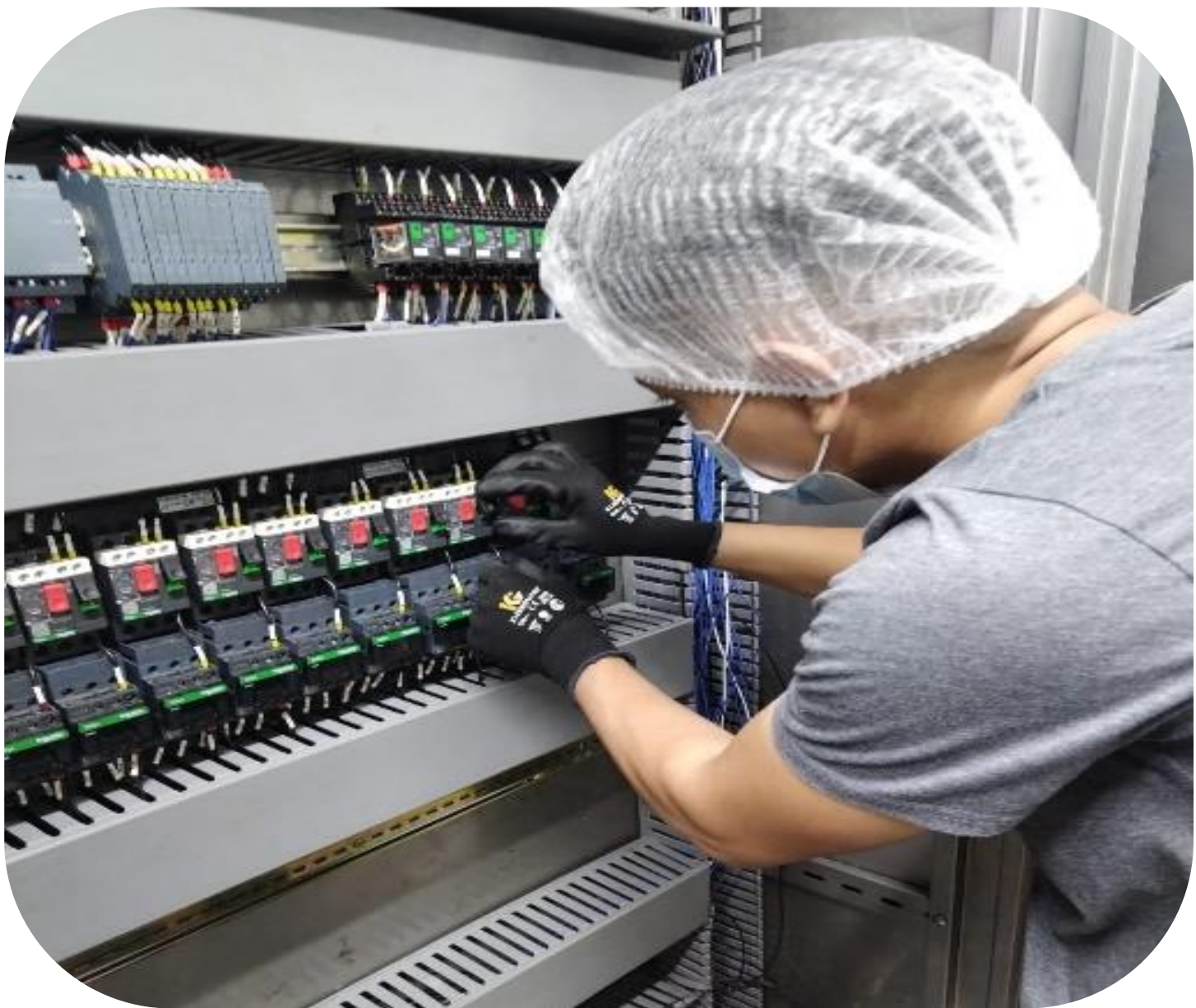
Inspección y diagnóstico de las conexiones eléctricas actuales tablero de control y fuerza del enjaulador de latas de atún
