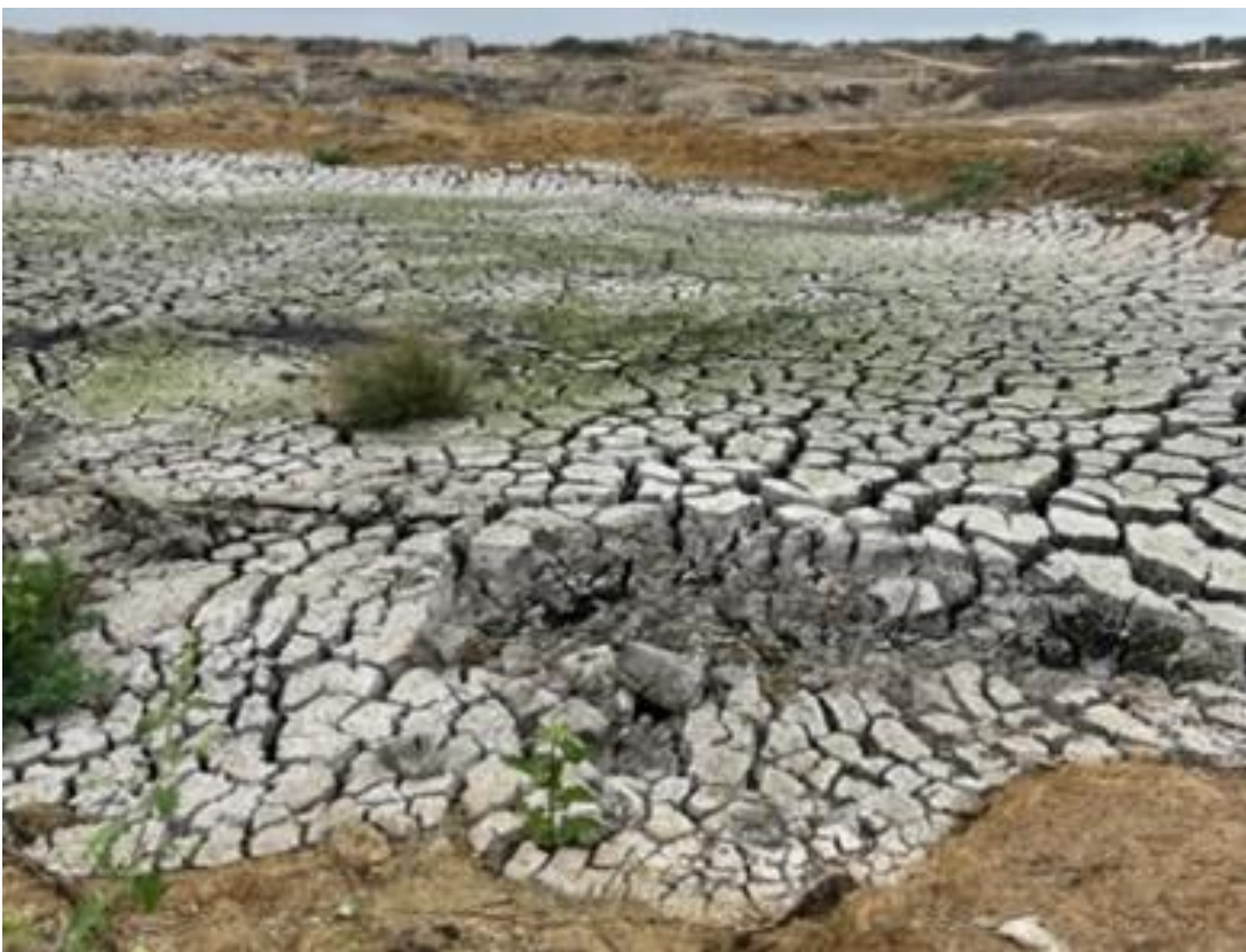
Ilustración 1: Lecho de secado del lodo proveniente de lagunas de oxidación anaerobias
