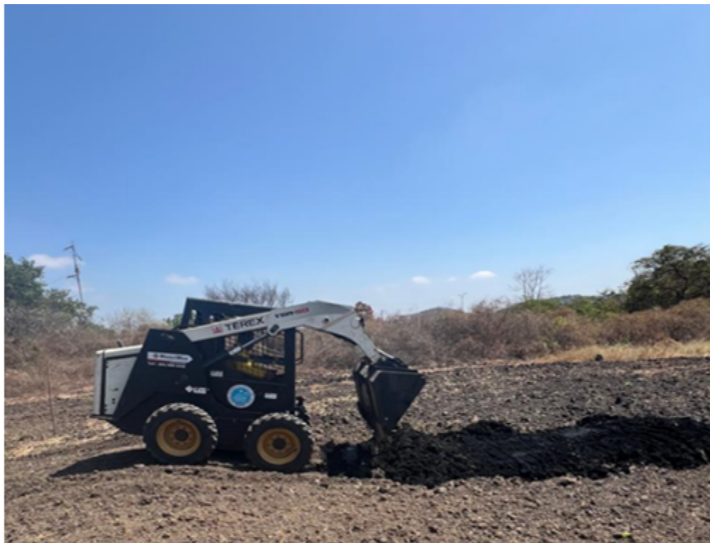
Figura 2. Proceso de aplicación de lodos residuales por tratamiento.
