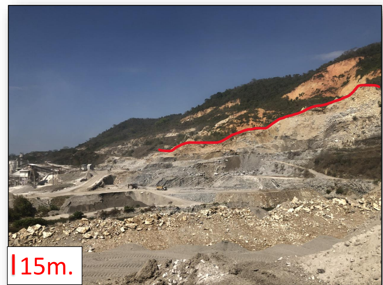
Foto de la cantera donde se aprecia el deslizamiento en estudio.
