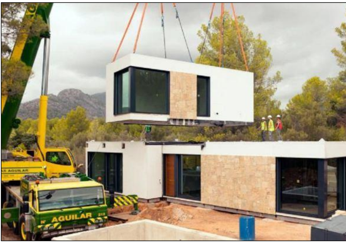
Construcción en fábrica y ensamblaje in situ
