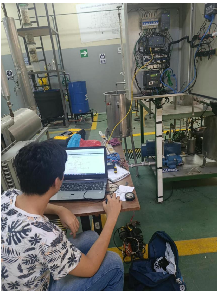
Carga del programa que realiza el control PI al PLC LOGO! 230rce
