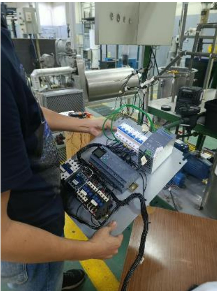
Desmontaje de los componentes del tablero de control
