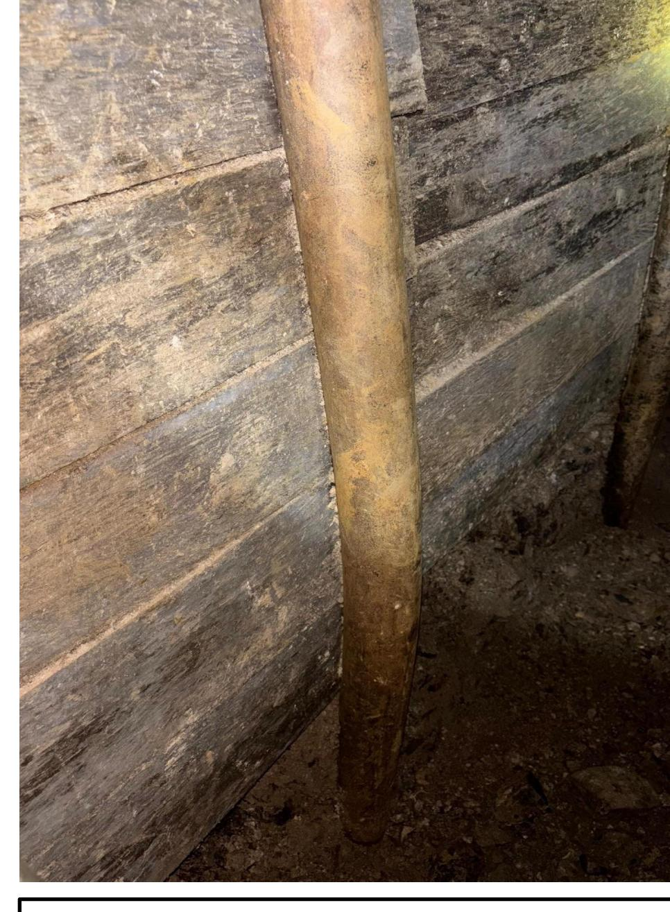
Figura 1. Deformación visible del tubo de sostenimiento
