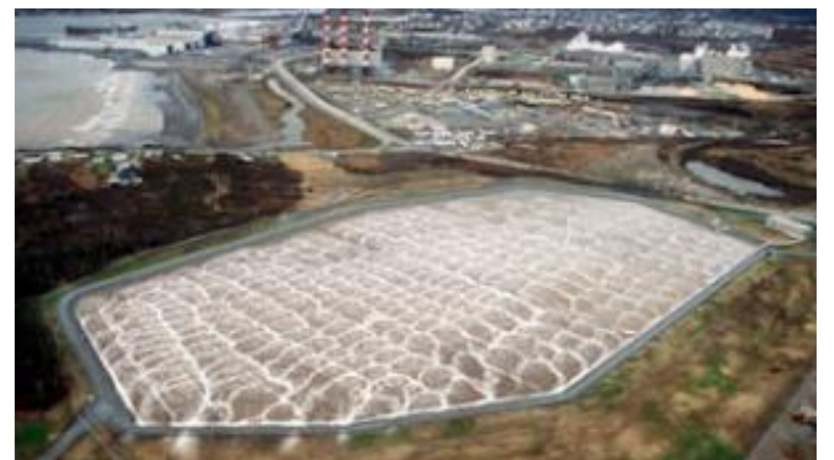
Gráfico 4. Esquema típico de una laguna aireada.
