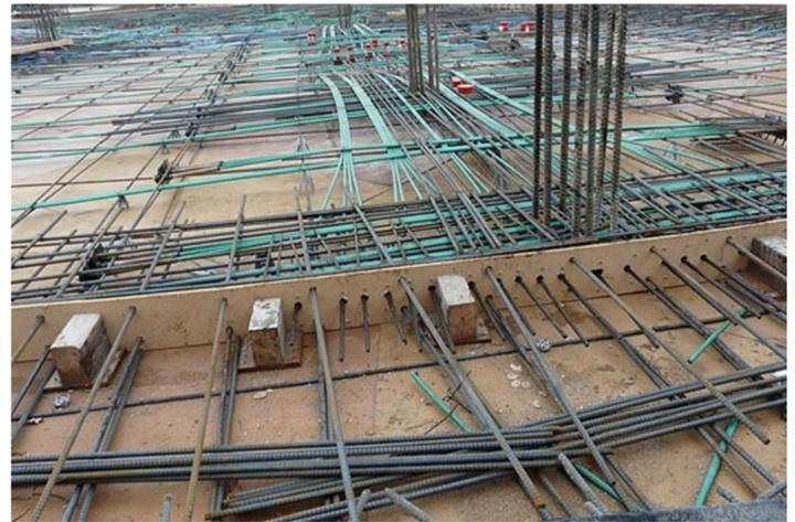
Figura 1. Sistema de losa postensada obtenida de Ergon Infra (2018).
