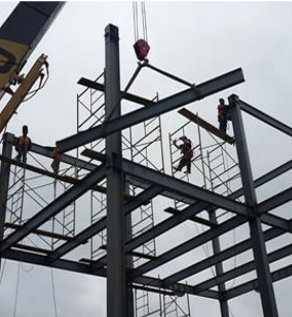
Figura 4. Montaje de acero estructural obtenido de Canva Pro.
