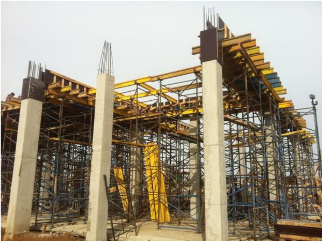
Fundición de elementos estructurales.
