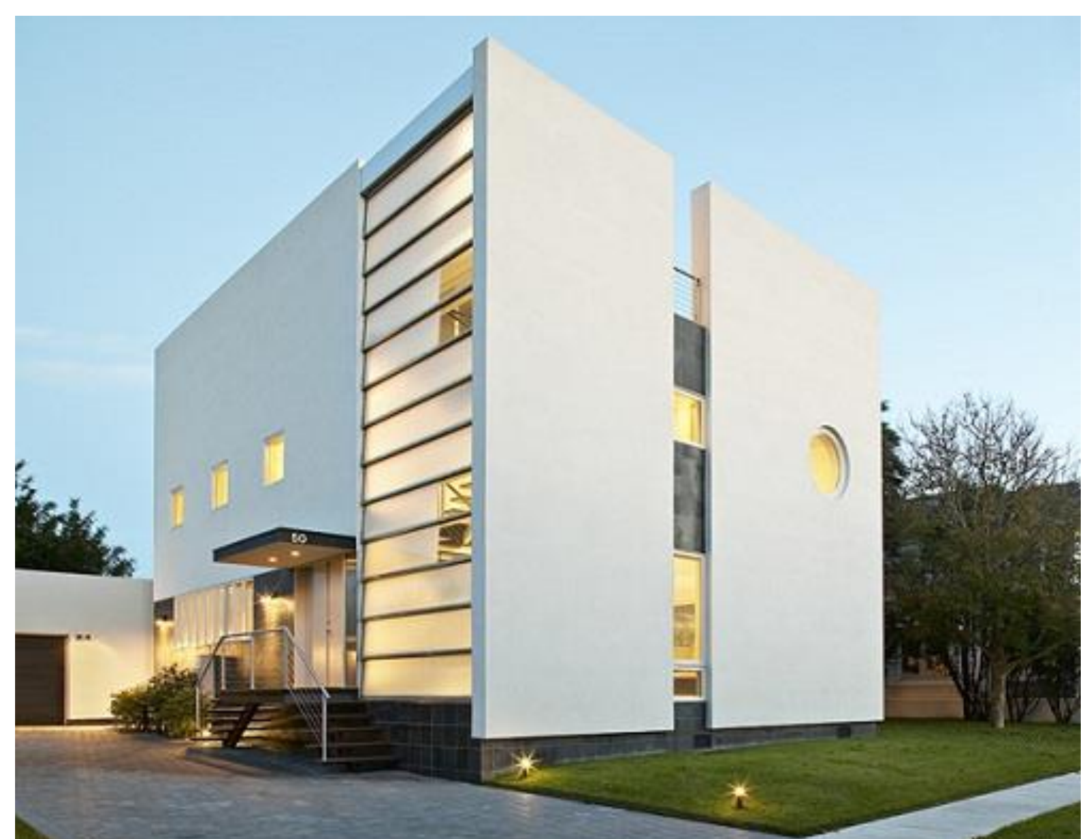
Figura 1.- Ejemplo de edificación que usa sistemas de aires acondicionados centralizados
