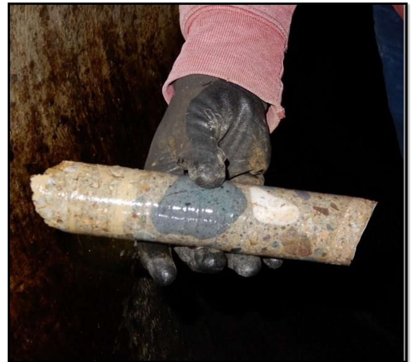
Extracción de muestras de hormigón para los estudios realizados con el aparato de ultrasonido.
