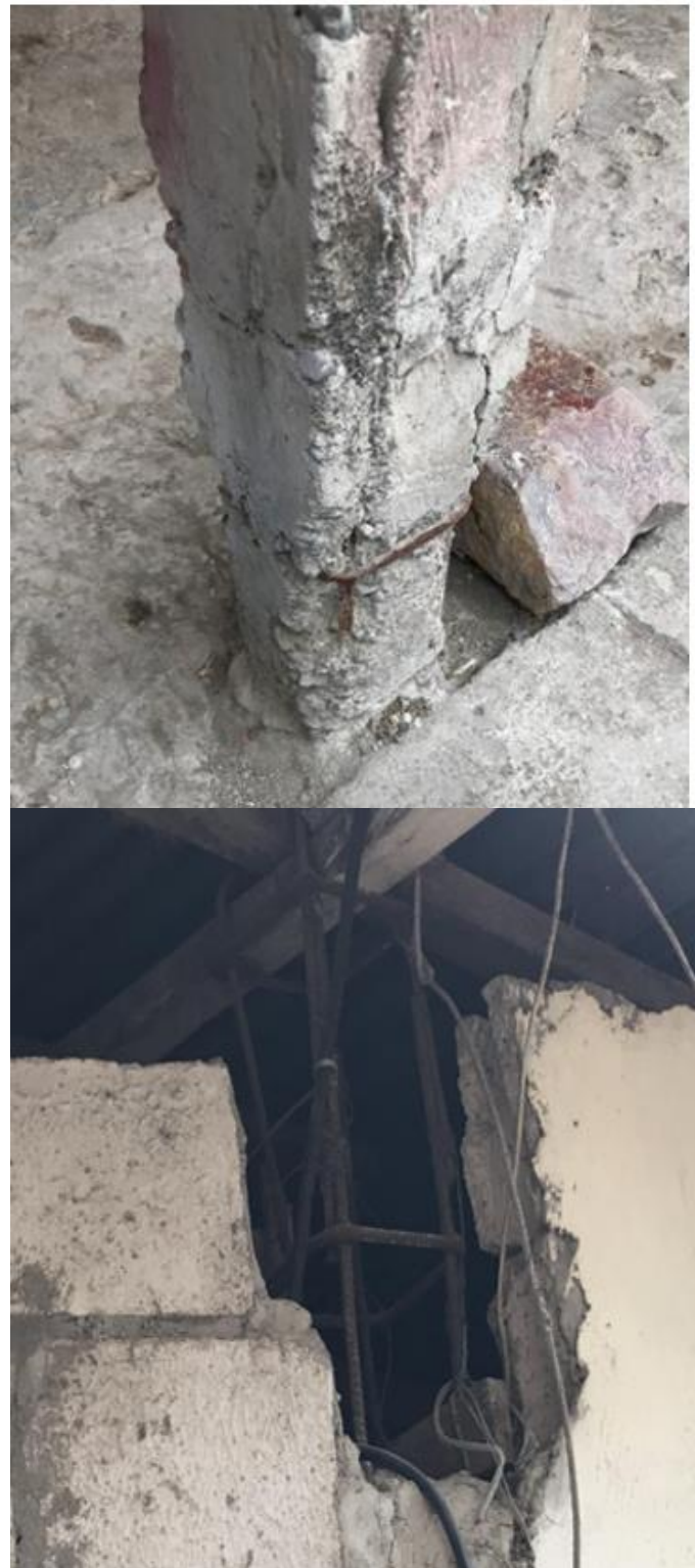
Figura 5. Esquema de deficiencia ( Izquierda ) y su reparación local ( Derecha )
