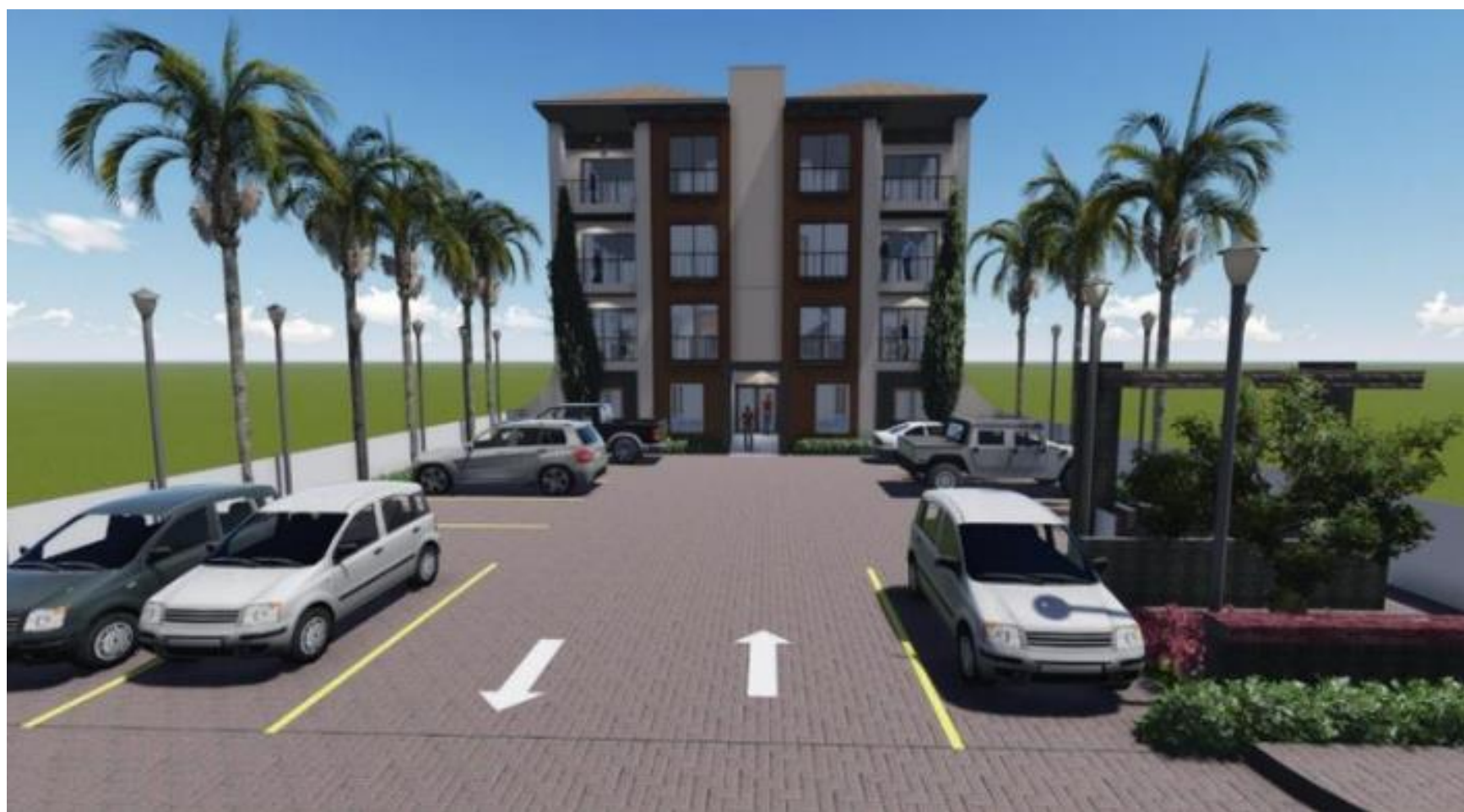
Vista frontal [Fuente propia]
