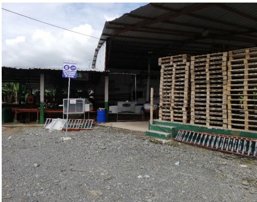
Falta de áreas de almacenamientos
